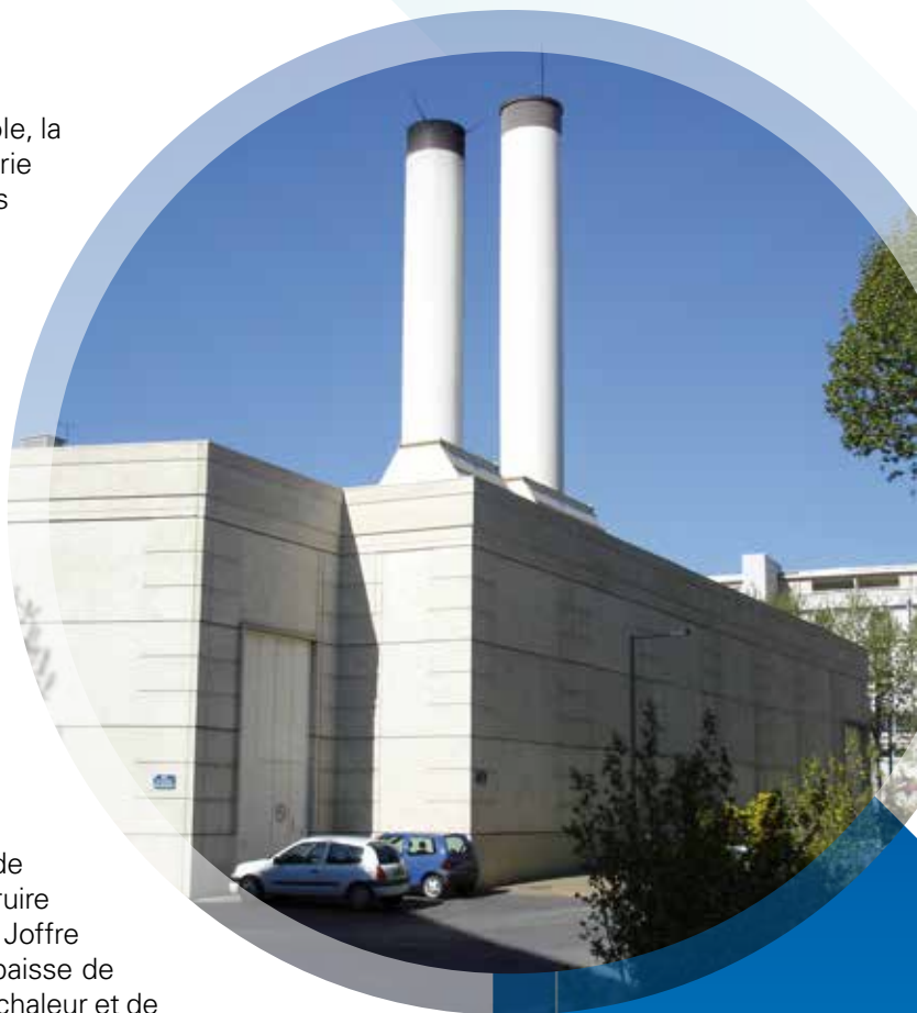
Conversion au bois de la chaufferie charbon d'Antigone
