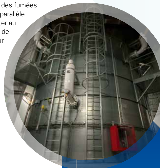
Silo de stockage de 210 m 3
