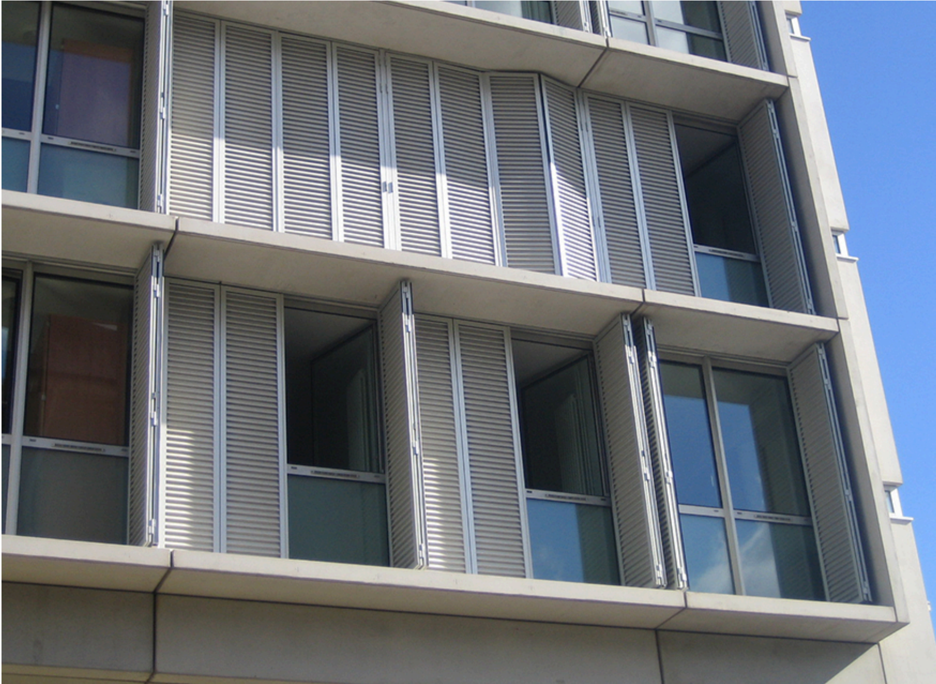
Dispositif de volets persiennes fixes, partiellement repliables
