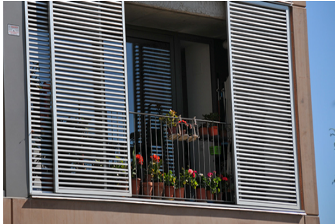
Dispositif de persiennes fixes, partiellement repliables
