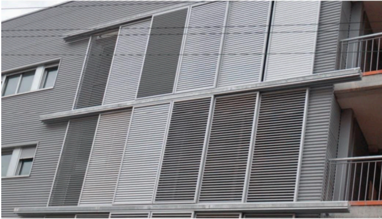
Dispositif de persiennes fixes, partiellement repliables
