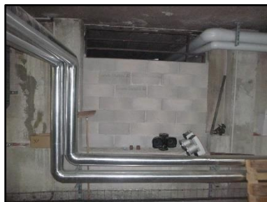
Liaison entre le sous-sol (parking) et la sous-station principale via une cloison en agglomérés située derrière une place de parking
