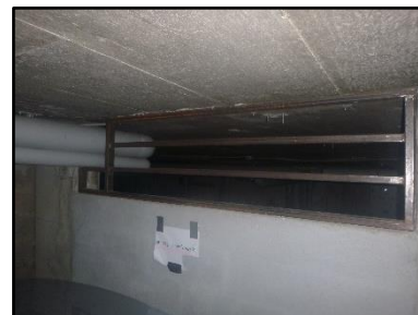
Liaison entre le sous-sol (parking) et la sous-station principale via une cloison en agglomérés située derrière une place de parking
