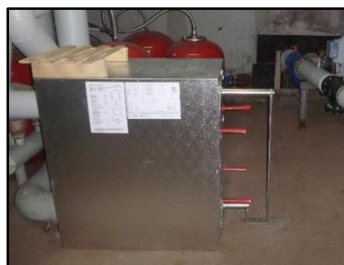
Echangeur à plaques
